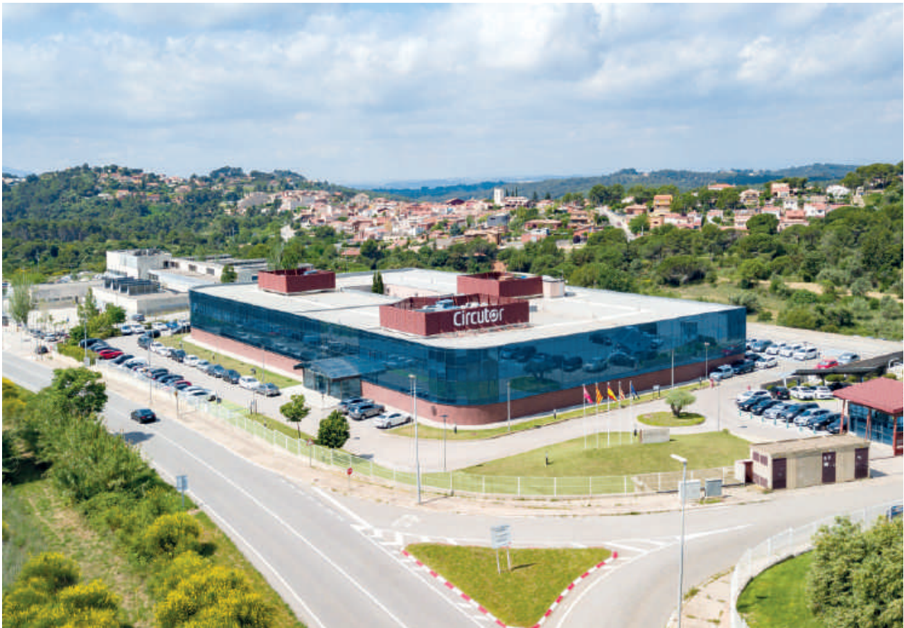
Sede central de CIRCUITOR en Viladecavalls, Barcelona.
